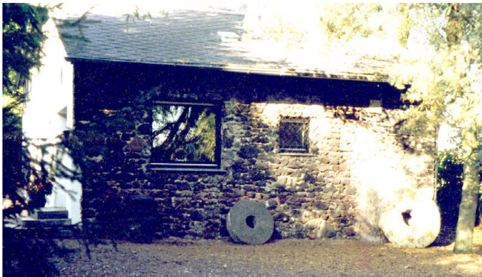
Die Sprinker Mühle in den 1980iger Jahren, Rückseite
